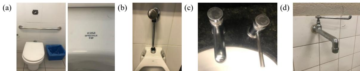
**Figura 3:** Instalações hidrossanitárias: (a) bacia sanitária; (b) mictório e válvula de descarga; (c) torneira para banheiro; e (d) torneira clínica de parede. Fonte: elaborado pelos autores.
