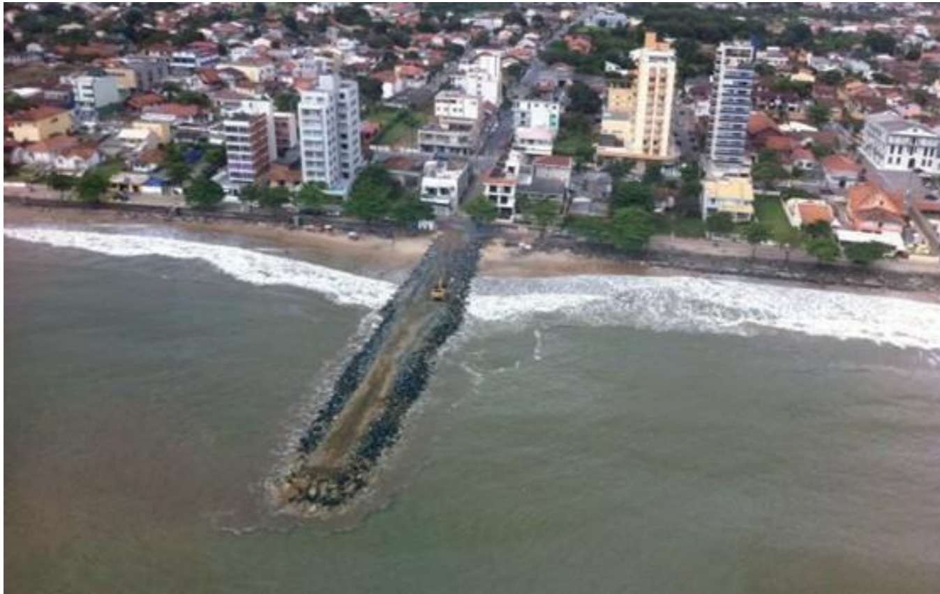
Imagem 14: Obra de recuperação da faixa de areia da Praia do Balneário Piçarras. Fonte: Blog Marco Lyra < http://marcolyra.blogspot.com/2012/01/balneario-picarras-in-veste-r12milhoes.html > Acesso em 30/05/2020
