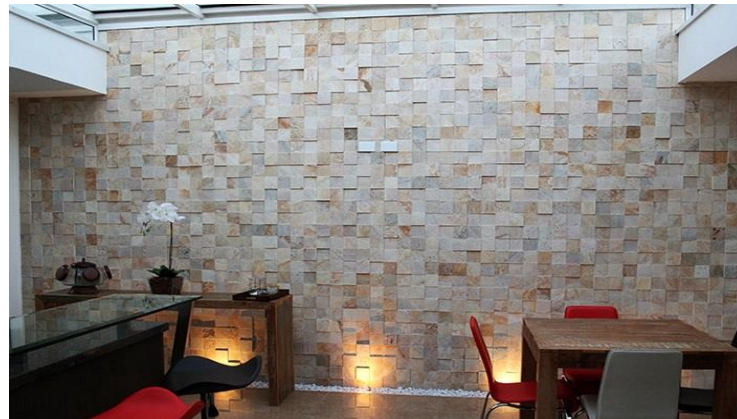
Figura 5: Revestimento de Pedra São Tomé. Fonte: Rochas Brasil.
