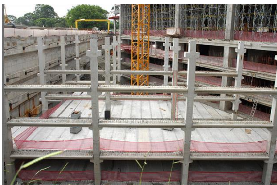
Figura 2: Estrutura pré-fabricada do Parque da Cidade. Fonte: PARQUE..., 2015.
