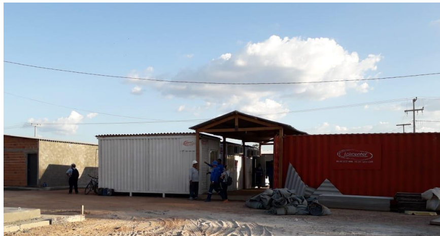
Figura 2: Administração parte de contêineres. Fonte: elaborado pelos autores.
