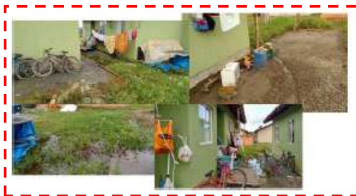
Imagem 4 – Água parada no fundo do lote, sistema de drenagem executado pelo beneficiário.
