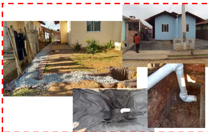
Imagem 7 - Representa a execução do sistema de drenagem no solo (imagens do autor)
