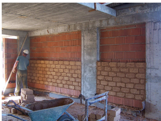
Figura 9: Execução Alvenaria. Fonte: AlmaVerde.
