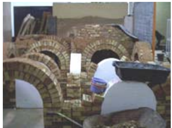
Canteiro Experimental – École d'Architecture de Grenoble Foto: Valter Caldana/2002
