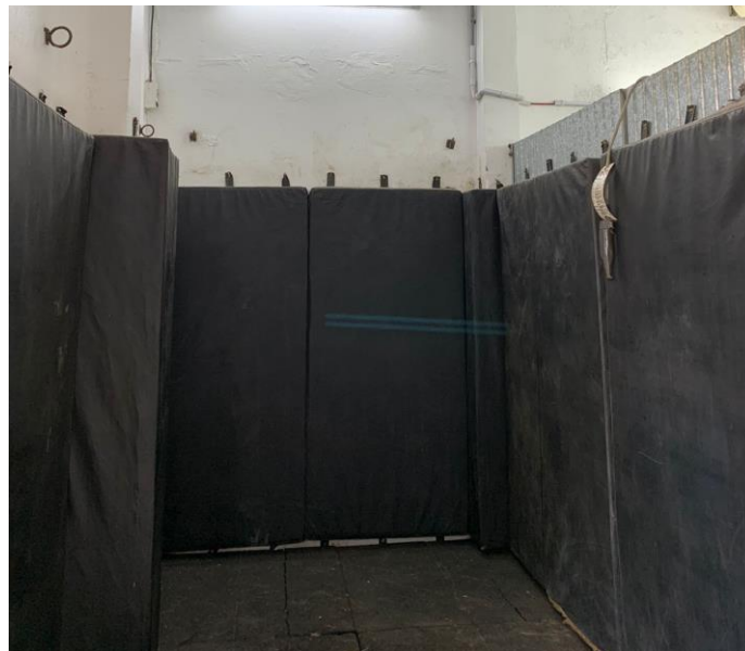
Figura 16 – Sala de indução anestésica com paredes estofadas e piso emborrachado.
