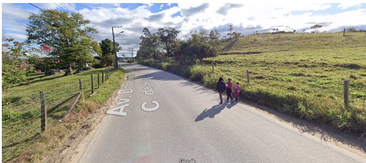
Imagem 46 - Ausência de calçamento no entorno do Condomínio Residencial Saudade.
