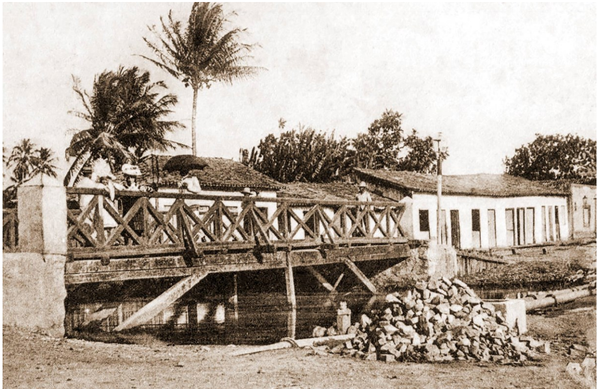
FIGURA 20 - PONTE DE BEBEDOURO, EM MACEIÓ, NO INÍCIO DO SÉCULO XX
