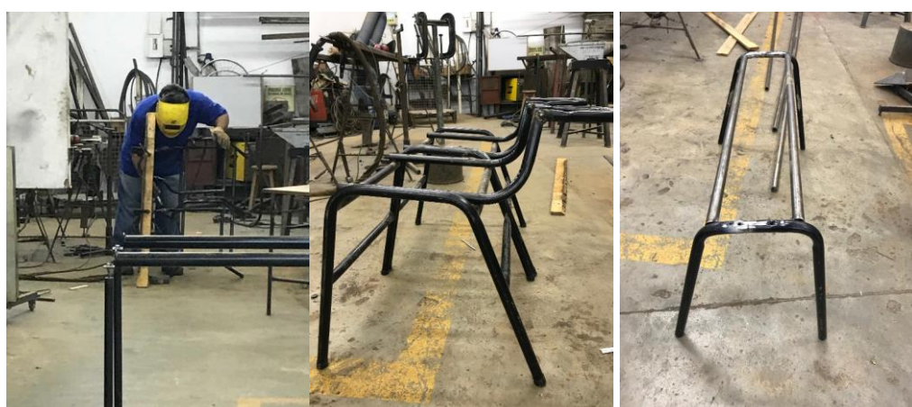
Figura 7: Fixação por soldagem das peças. Fonte: elaborado pelos autores.
