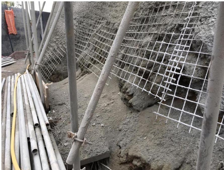
Figura 5: Desperdício de material devido à não adesão da mistura no talude. Fonte: elaborado pelos autores.
