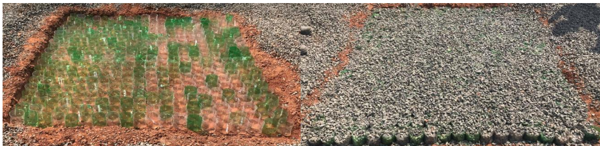
Figura 3: Escavação e Instalação das geocélulas. Fonte: elaborado pelos autores.
