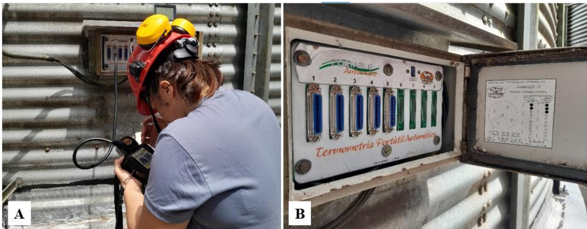
Figura 31 – Termometria dos silos de armazenamento de grãos de milho. A: funcionária realizando a termometria do silo de armazenamento de grãos de milho. B fonte dos sensores de temperatura com legenda da disposição dos mesmos no silo.
