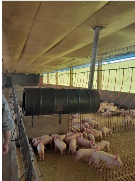
Figura 9 – Fornalha interna para aquecimento de granja de creche.
