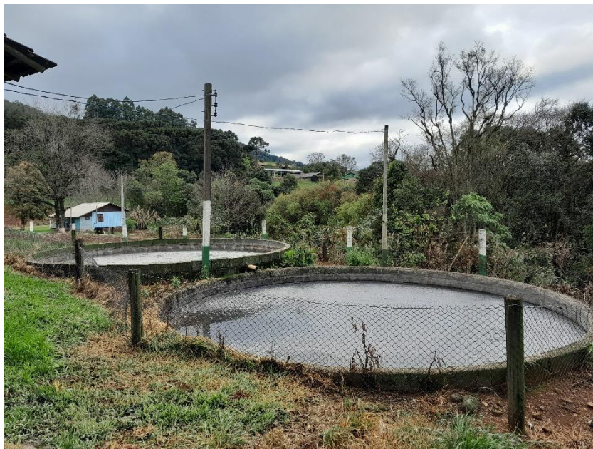
Figura 12 – Esterqueira para acondicionar dejetos de suínos.
