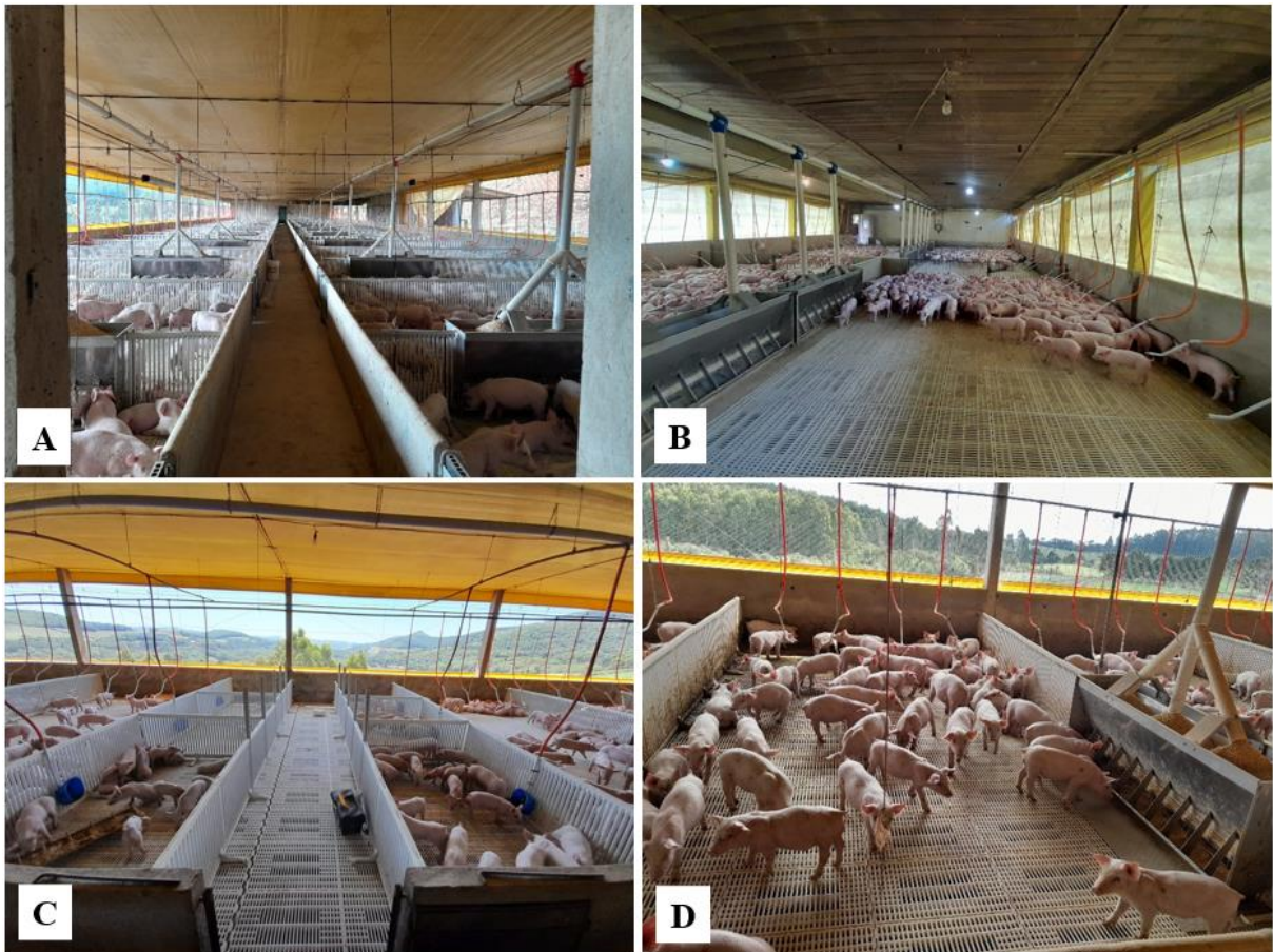
Figura 4 – Estrutura externa das granjas de creche. A: disposição de duas fileiras de baias com corredor central. B: disposição de baias separadas por comedouros com corredor lateral. C: baias destinadas para enfermaria. D: piso vazado em plástico por toda a extensão da baia.
