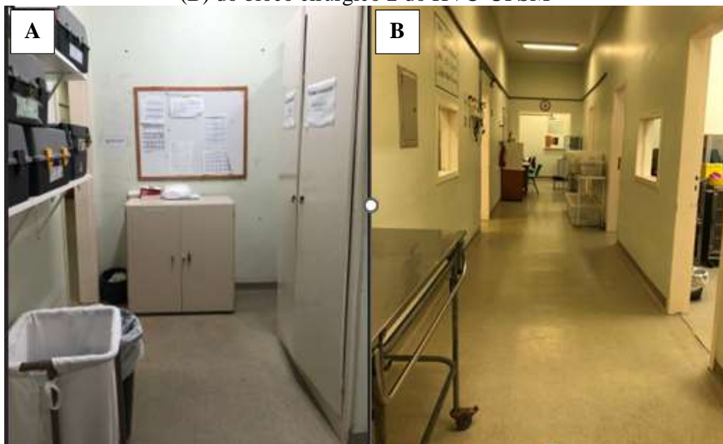
Figura 8 – Transição da área suja (A) para área limpa (B) do bloco cirúrgico 2 do HVU-UFSM
