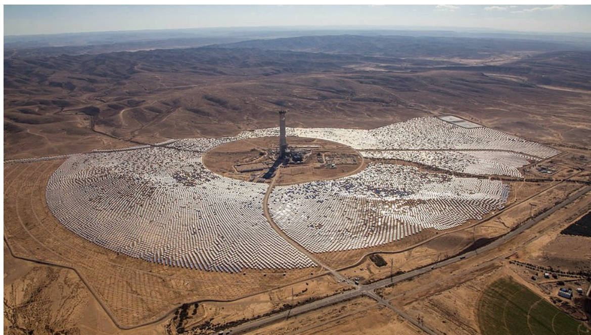
Figura 10 – Maior torre de concentração solar com heliostatos, localizada em Ashalim e encontra-se nas areias do deserto do Negev.
