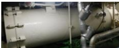
Figura 30 – Tanque de amônia da embarcação.
