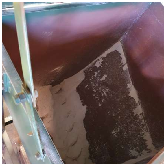
Figura 62 – Vista interna da caixa de farinha
