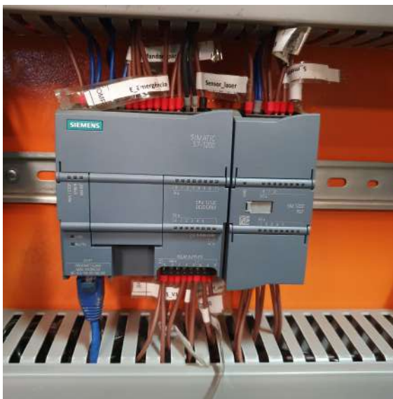
Figura 11 – CLP S7 1200 SIEMENS com um módulo de expansão
