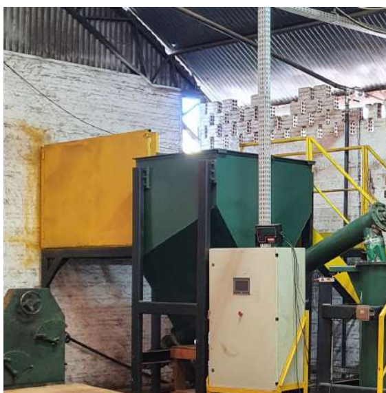
Figura 29 – Local Projetado Para o Armazenamento do Pallet de Farinha
