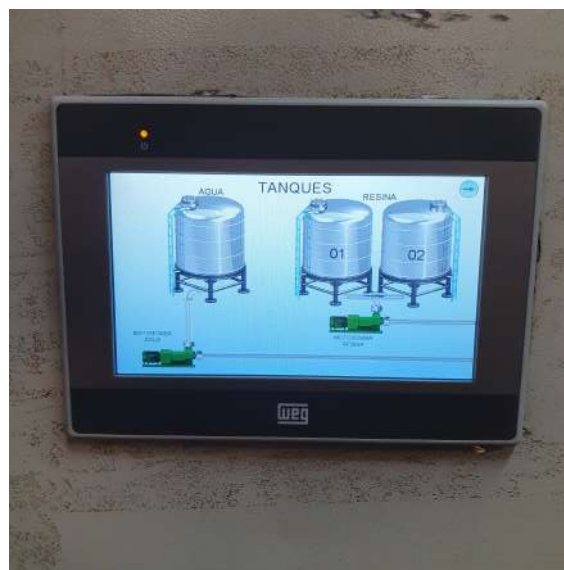
Figura 13 – IHM utilizada no projeto de planta de colagem estudada neste documento. Tela de operação dos tanques de resina pura.
