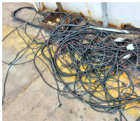
Figura 17 – Cabeamento elétrico removido de uma embarcação em reforma.
