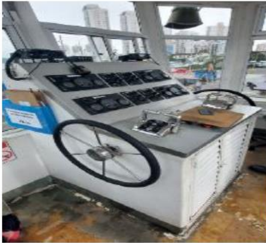
Foto 19 - Painel de comando.
