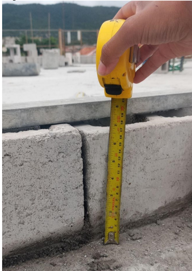
Figura 24 - Primeira fiada assentada com blocos cortados
