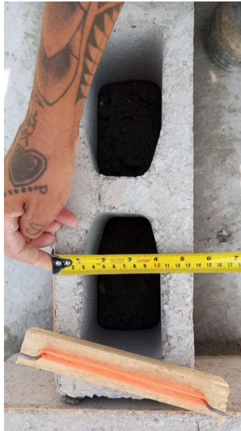
Figura 22 - Bloco de concreto com 0,5cm a menos de espessura
