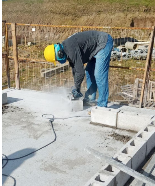
Figura 25 - Bloqueiro cortando bloco de concreto
