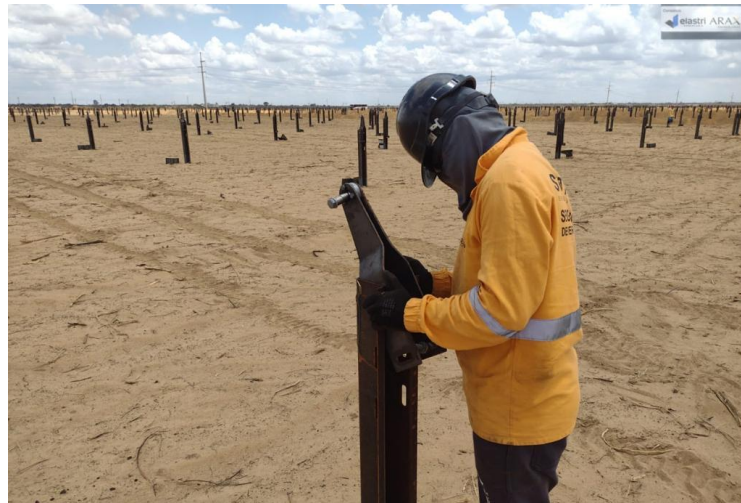
Figura 19: Montagem de cabeça de estaca
