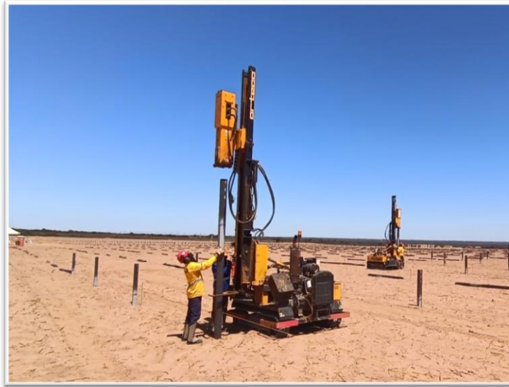
Figura 14: Bate-estaca realizando a cravação de estaca de fundação
