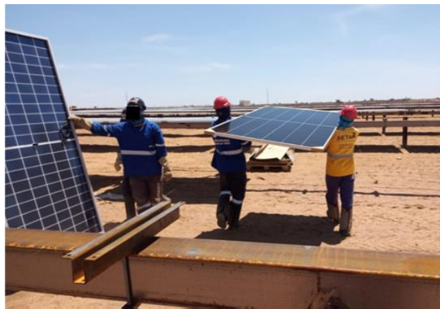
Figura 30: Posicionamento do módulo sobre a estrutura de suporte
