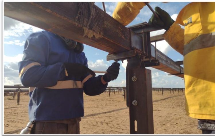
Figura 28: Montadores realizando a instalação do suporte de módulo
