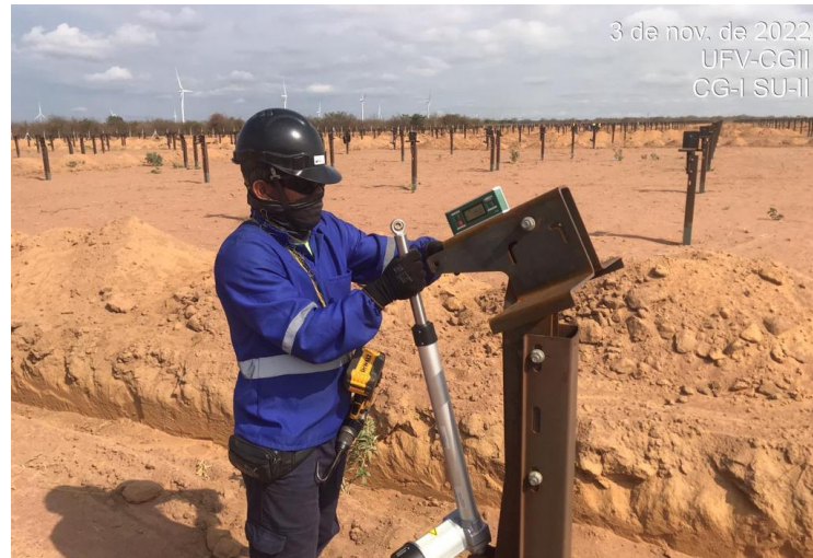
Figura 23: Instalação do atuador
