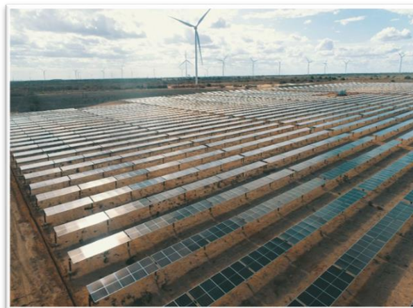
Figura 31: Parte da UFV com as estruturas de trackers e módulos finalizadas
