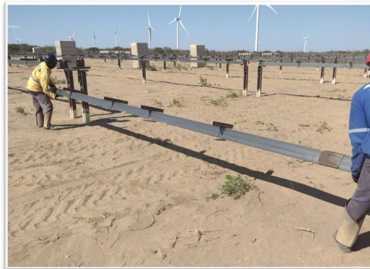
Figura 24: Operários realizando o içamento de main-beam
