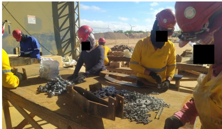
Figura 16: Montadores realizando a pré-montagem de cabeça de estaca
