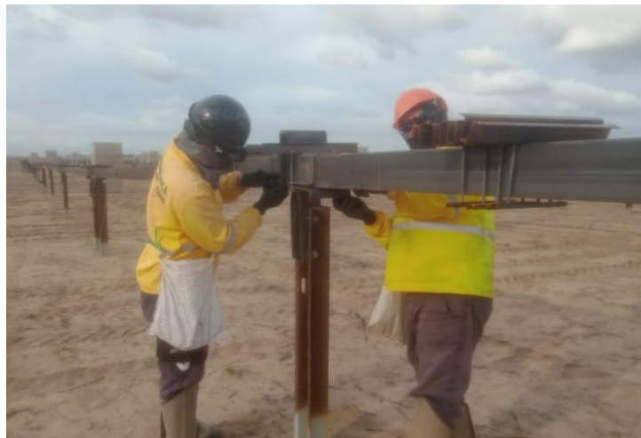
Figura 26: Operários realizando o torque das gravatas
