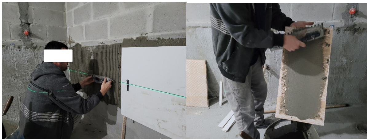
Figura 20 - Aplicação de argamassa em dupla colagem.
