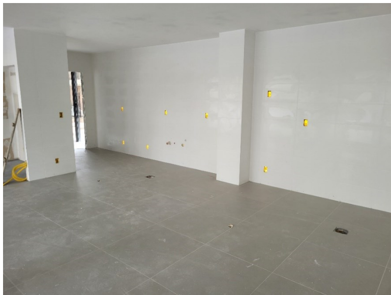
Figura 16 - Revestimento de parede e piso das lojas do térreo.
