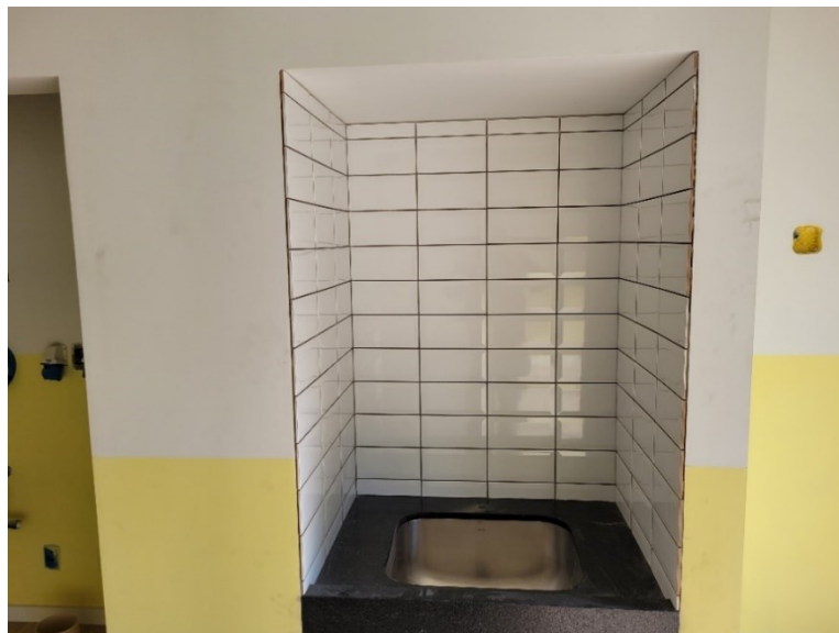
Figura 14 - Lavanderia do segundo pavimento da torre A.
