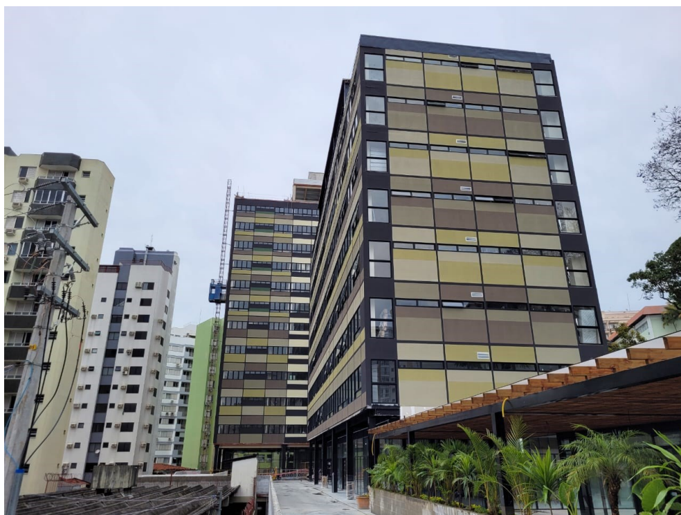
Figura 9 - Empreendimento obra Z, localizado em Florianópolis/SC.
