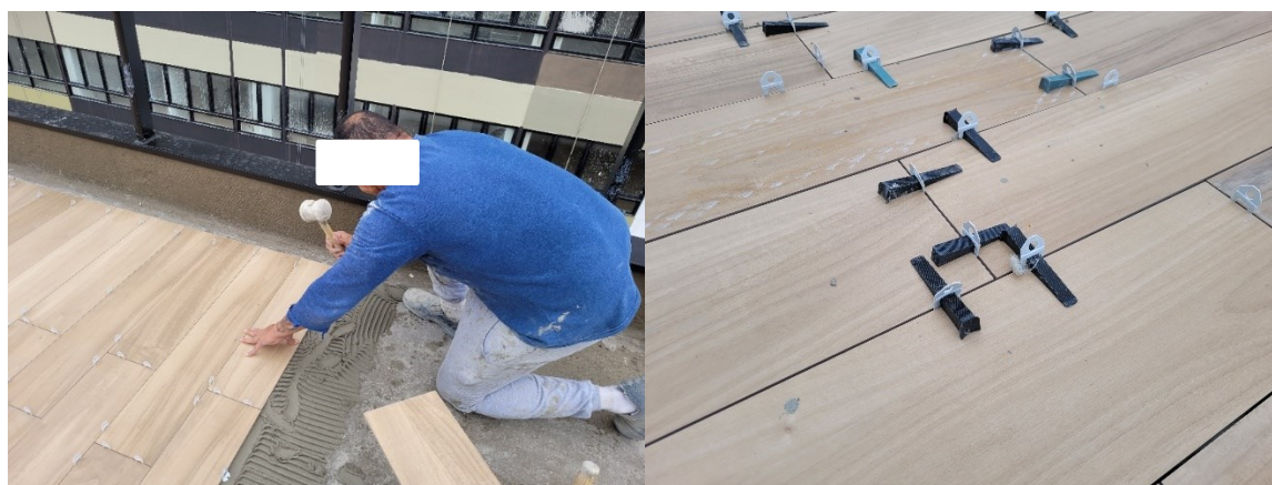
Figura 21 - Assentamento de placa cerâmica com niveladores de clipagem.
