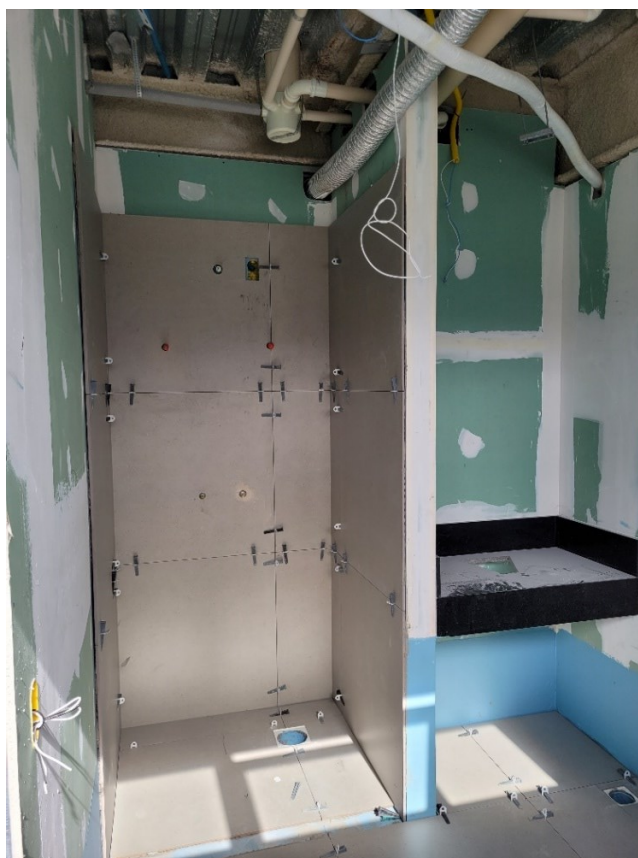
Figura 15 - Banheiros dos apartamentos das torres A e B.
