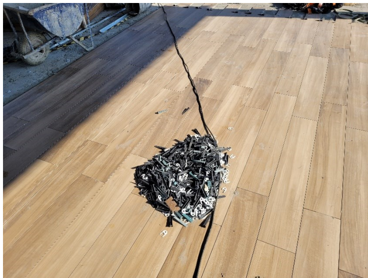
Figura 22 - Material empilhado após a limpeza final.
