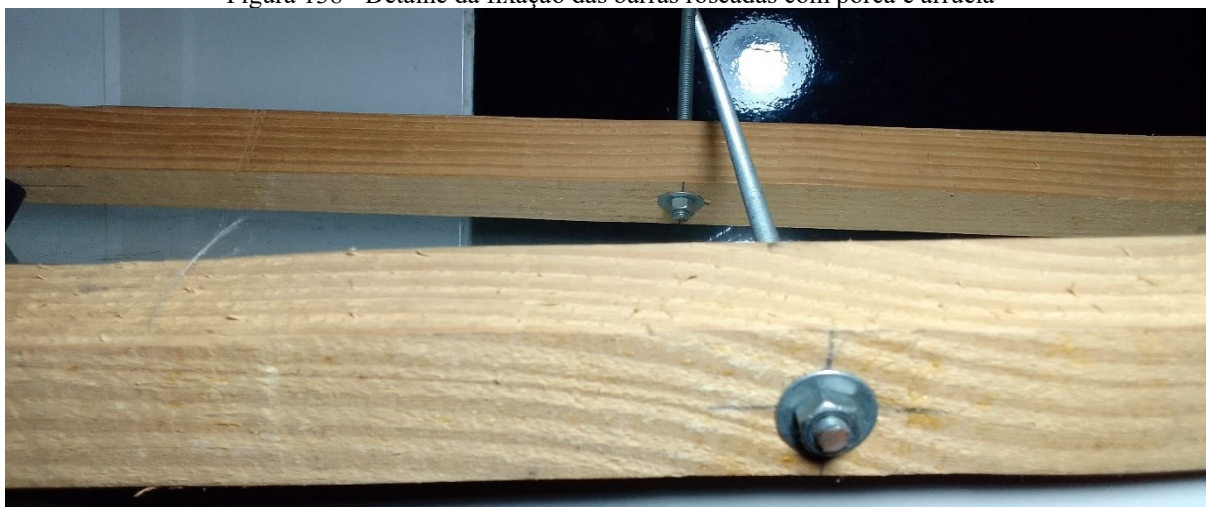
Figura 138 - Detalhe da fixação das barras roscadas com porca e arruela
