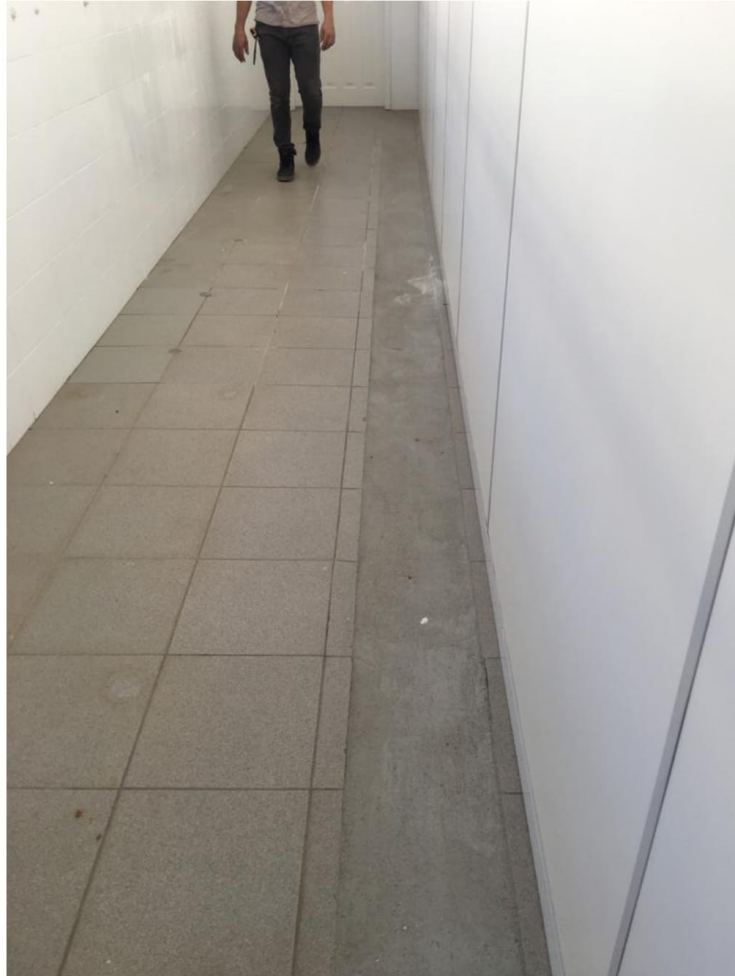
Figura 30: Divisória da cozinha para o corredor. (Fonte: Dos Autores 2020).
