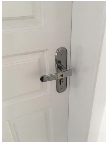
Figura 7: Maçaneta nova. (Fonte: Dos Autores 2020).
