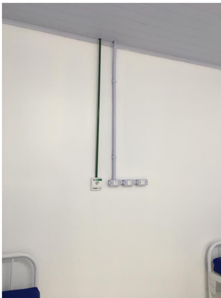
Figura 15: Sistema de oxigênio. (Fonte: Dos Autores 2020).
