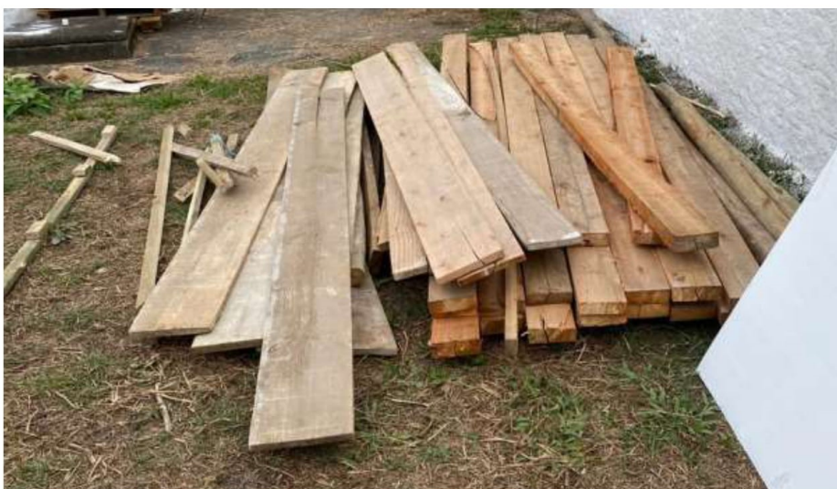
Figura 5: Materiais em contato direto com o solo (Fonte: Dos Autores 2020).
