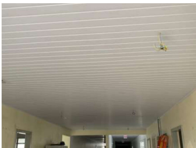
Figura 24: Forro recolocado. (Fonte: Dos Autores 2020).
