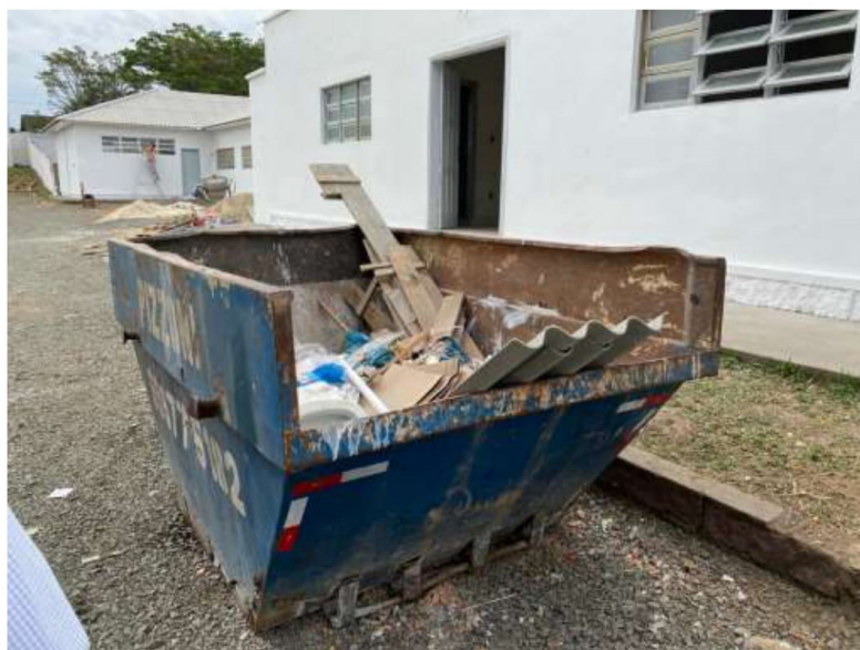
Figura 8: Entulhos de obra descartados corretamente. (Fonte: Dos Autores 2020).
