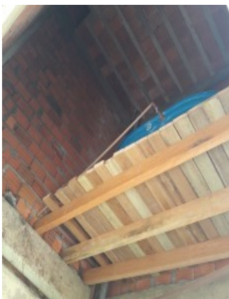
Caixa d'água provisória.
