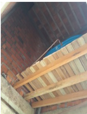
Caixa d'água provisória.
