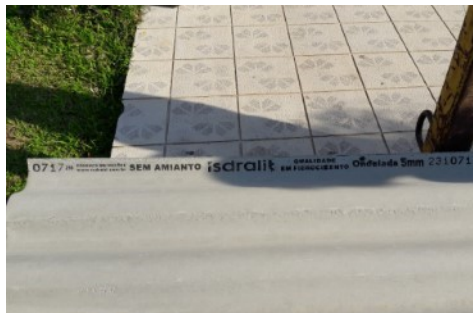
Telhas de fibrocimento diversas do solicitado na planilha orçamentária.
