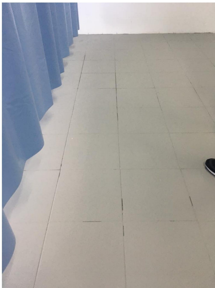
Figura 34: Chão com pintura emborrachada. (Fonte: Dos Autores 2020).
