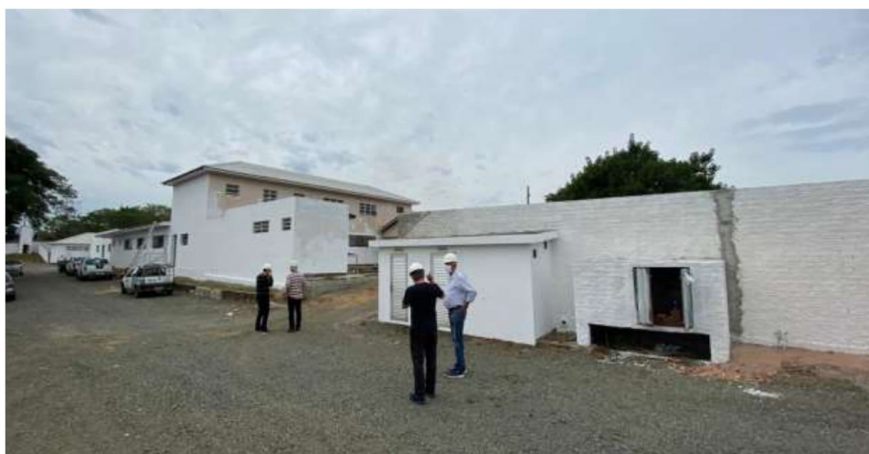
Figura 4: Fachada dos fundos. (Fonte: Dos Autores 2020).
