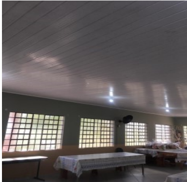
Forro com abaulamento
