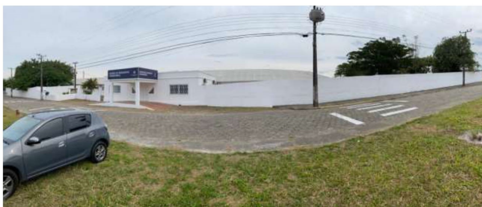
Figura 3: Fachada frontal. (Fonte: Dos Autores 2020).
