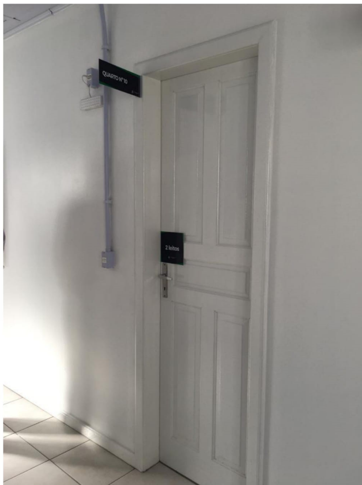
Figura 19: Porta de madeira. (Fonte: Dos Autores 2020).
