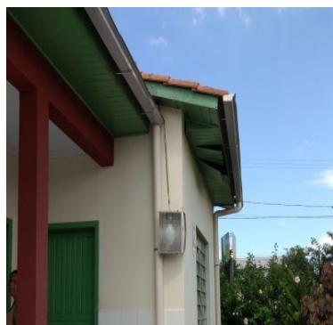
Deslocamento dos beirais de madeira.
