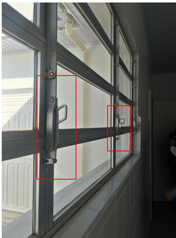
Figura 20: Restauração da janela sem padrão. (Fonte: Dos Autores 2020).
