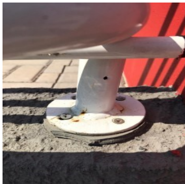
Corrimão da rampa.
