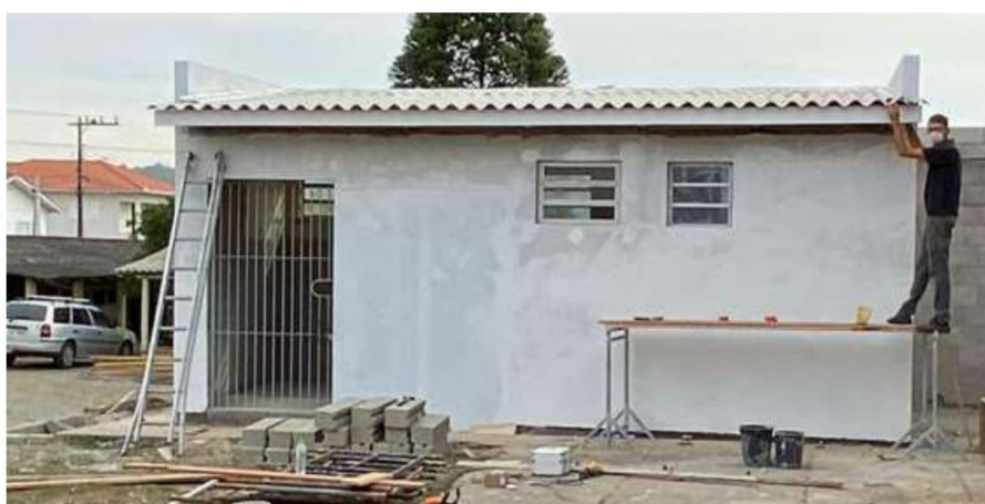
Figura 22: Central de gás. (Fonte: Dos Autores 2020).
