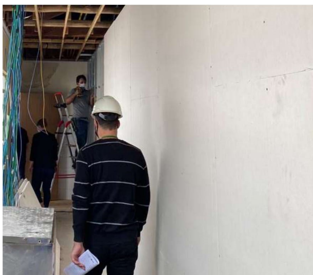
Figura 26: Parede de gesso acartonado a ser revestida. (Fonte: dos Autores 2020).
