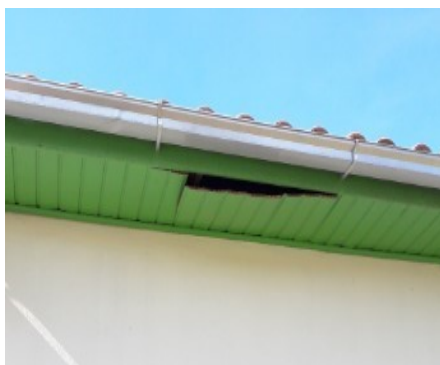
Deslocamento dos beirais de madeira.
