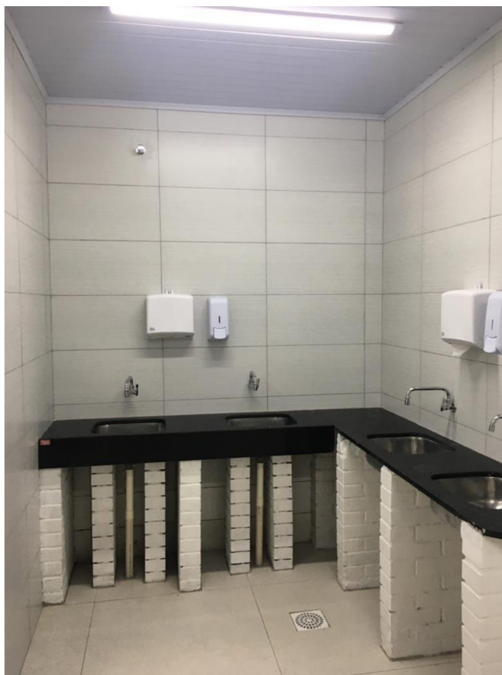
Figura 25: Paredes do banheiro revestidas. (Fonte: dos Autores 2020).
