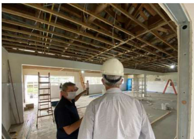
Figura 23: Forro a ser recolocado na ala semi-intensiva. (Fonte: Dos Autores 2020).
