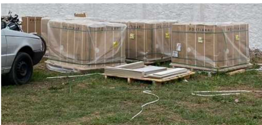
Figura 6: Materiais armazenados de forma correta. (Fonte: Dos Autores 2020).
