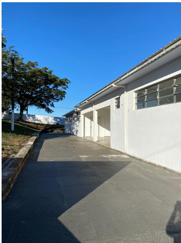
Figura 35: Chão concretado. (Fonte: Dos Autores 2020).
