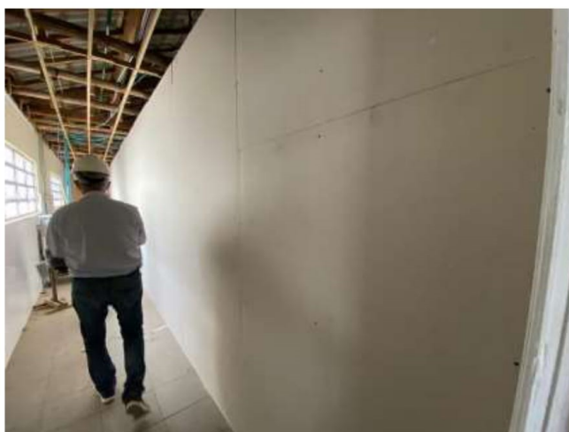
Figura 25: Parede de gesso acartonado a ser revestida. (Fonte: dos Autores 2020).
