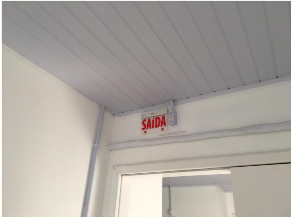
Figura 24: Saída emergencial. (Fonte: Dos Autores 2020).
