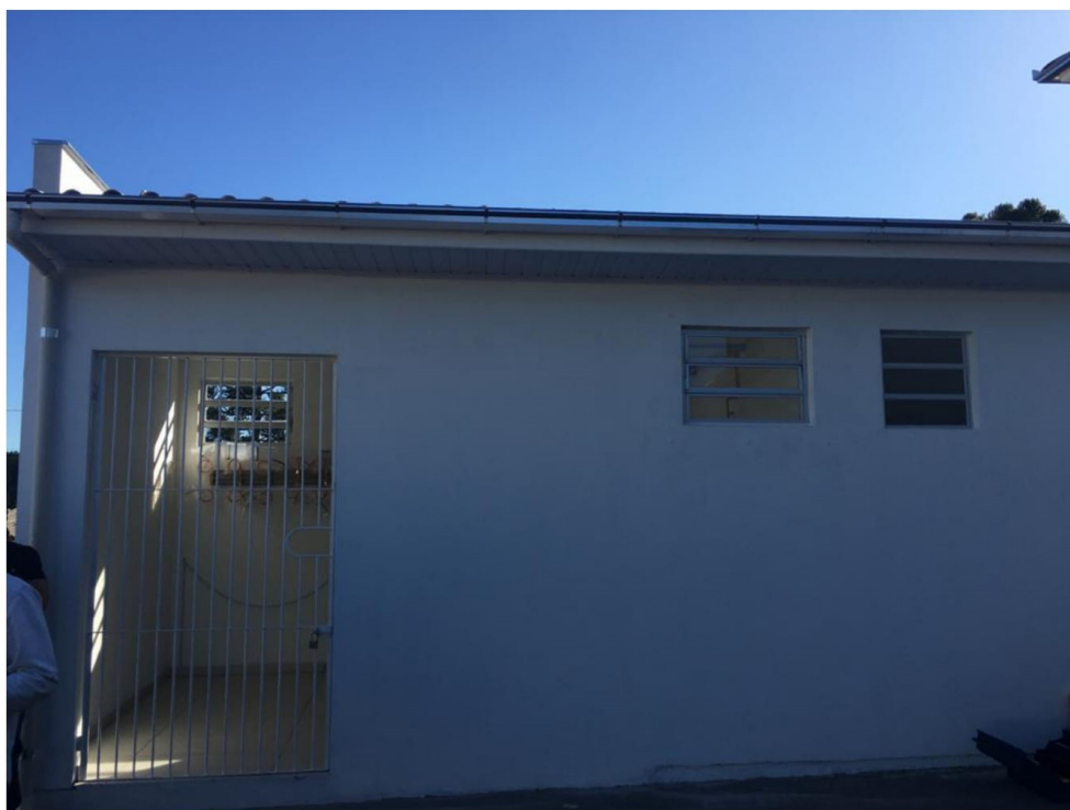
Figura 36: Local de armazenamento do oxigênio. (Fonte: Dos Autores 2020).
