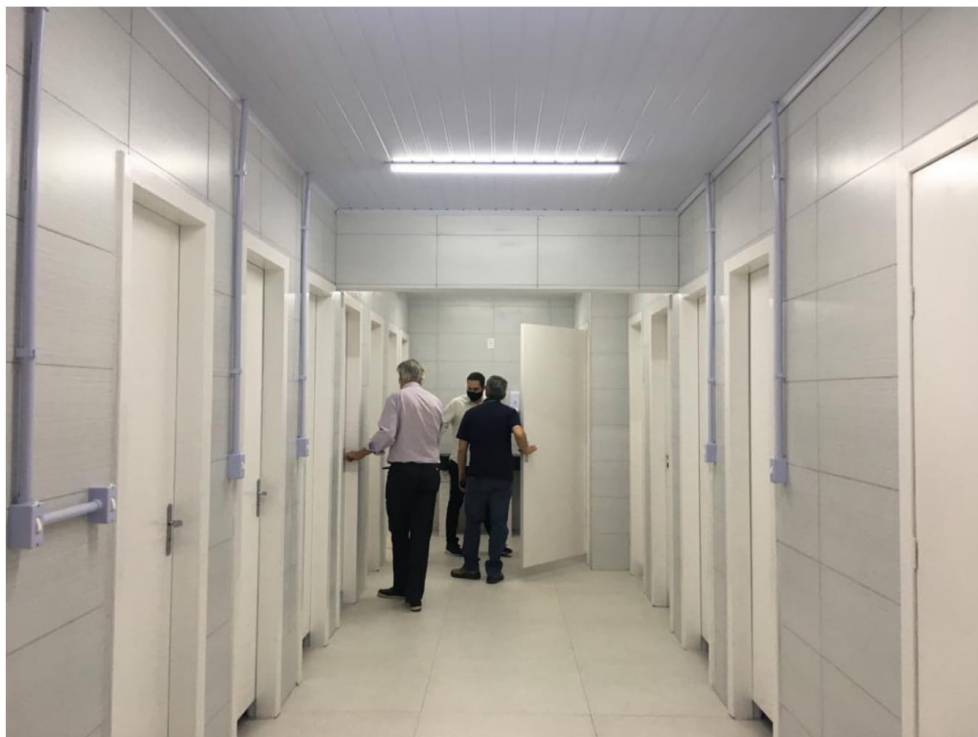
Figura 26: Banheiro revestido e portas novas. (Fonte: dos Autores 2020).
