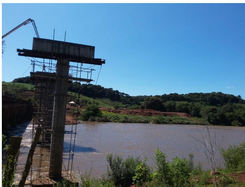
Figura 15 - P5 antes do alagamento consequente da barragem São Roque (07/02/2021).
