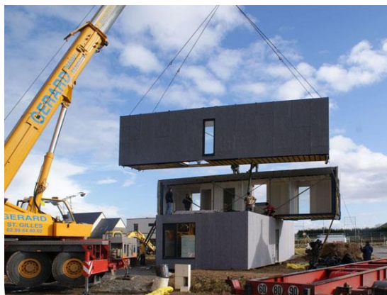
Figura 3: Transporte e instalação do contêiner no terreno. Fonte: Minha casa container (2014)
