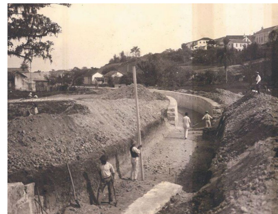
Figura 12: “Obra de Canalização do Rio da Bulha, 1919”. Fonte: Acervo da Casa da Memória.
