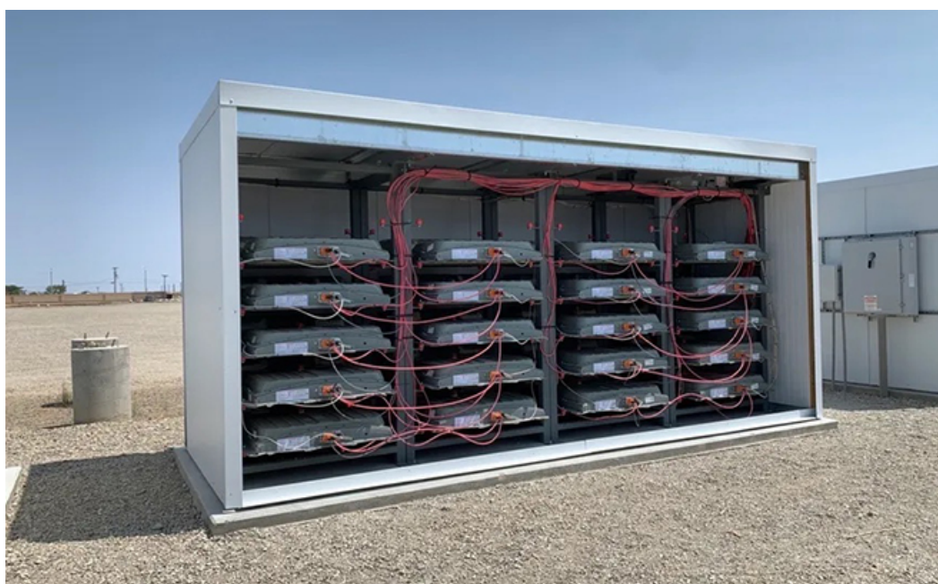
Figura 17 – Conjuntos de baterias do Nissan LEAF para aplicação em segunda vida.
