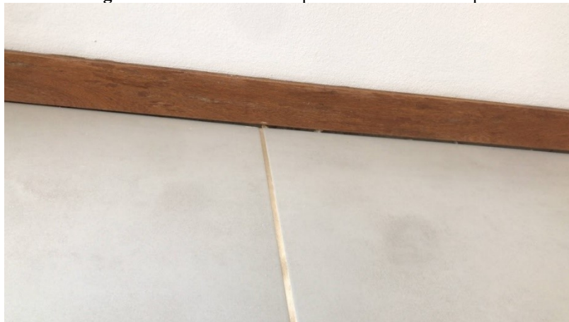
Figura 14. Desnível entre o piso cerâmico e o rodapé.
