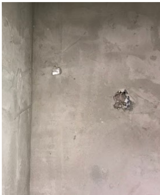
Figura 8. Falta de acabamento da caixa de tomada.
