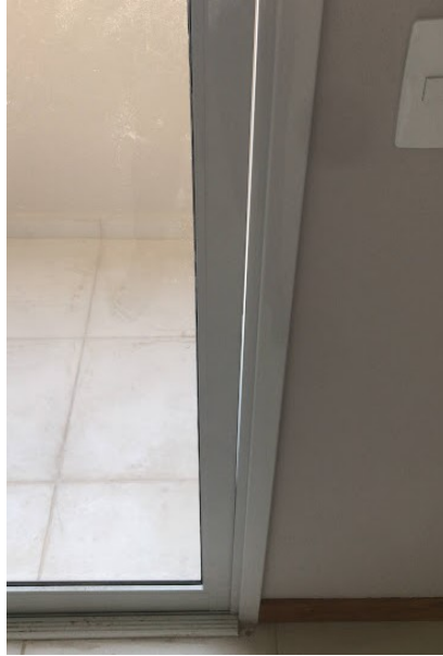
Figura 17. Esquadrias desalinhadas.
