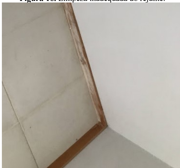
Figura 16. Limpeza inadequada do rejunte.
