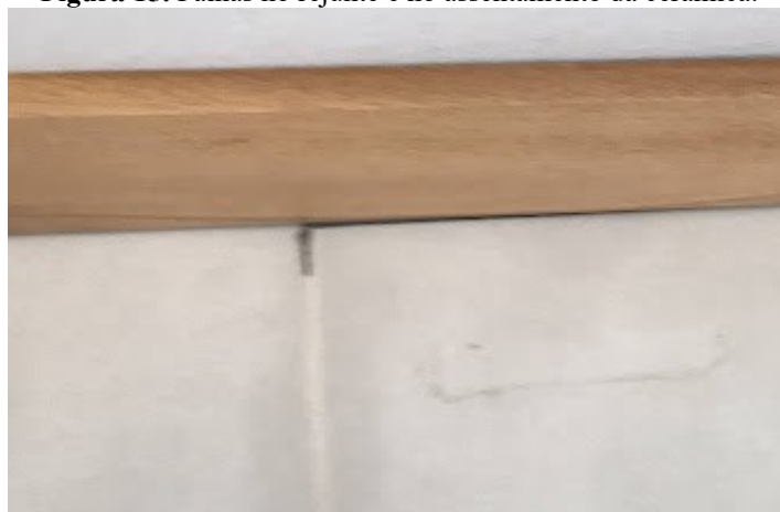
Figura 15. Falhas no rejunte e no assentamento da cerâmica.
