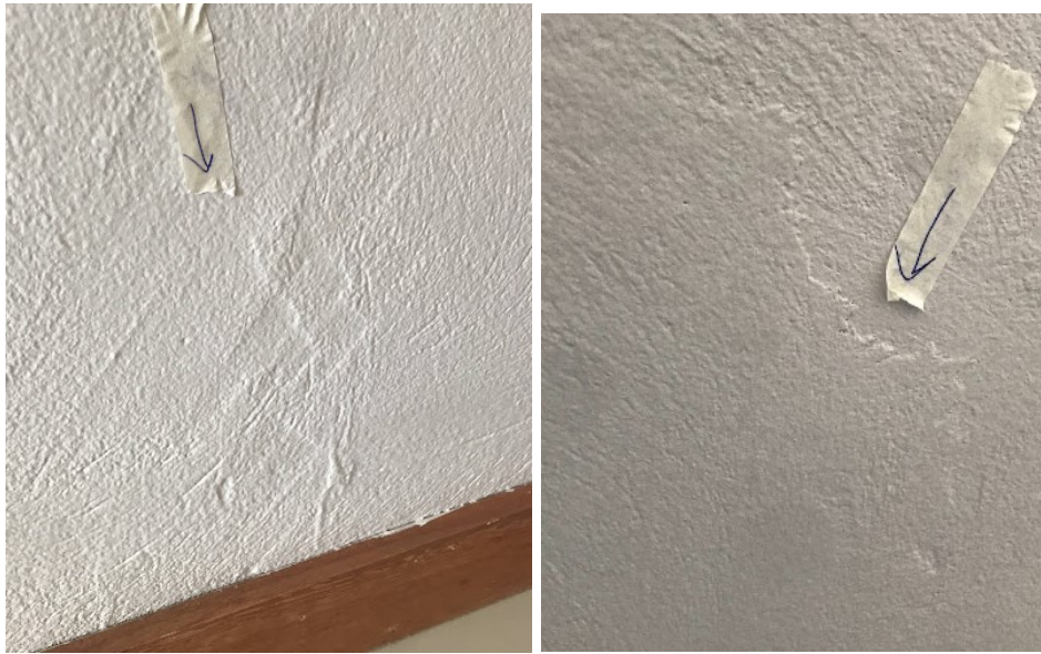
(i) Verificação do acabamento da parede
