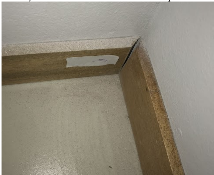
Figura 22. Peça recortada com dimensão inferior ao comprimento necessário.
