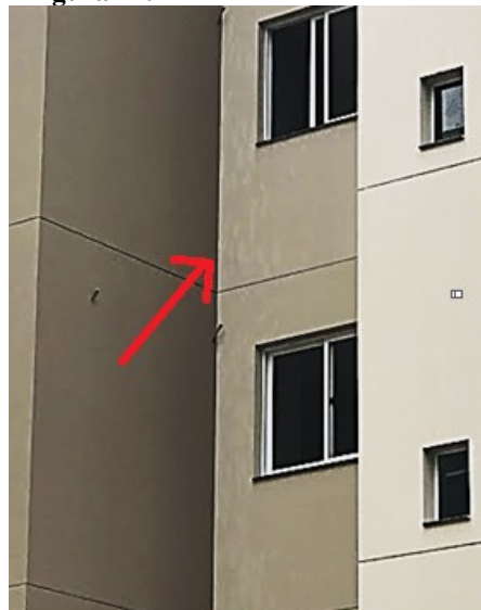
Figura 12. Pintura externa na fachada.
