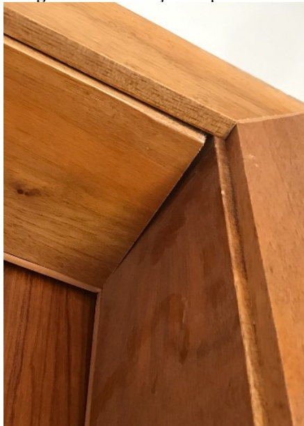
Figura 20. Guarnição da porta torta.
