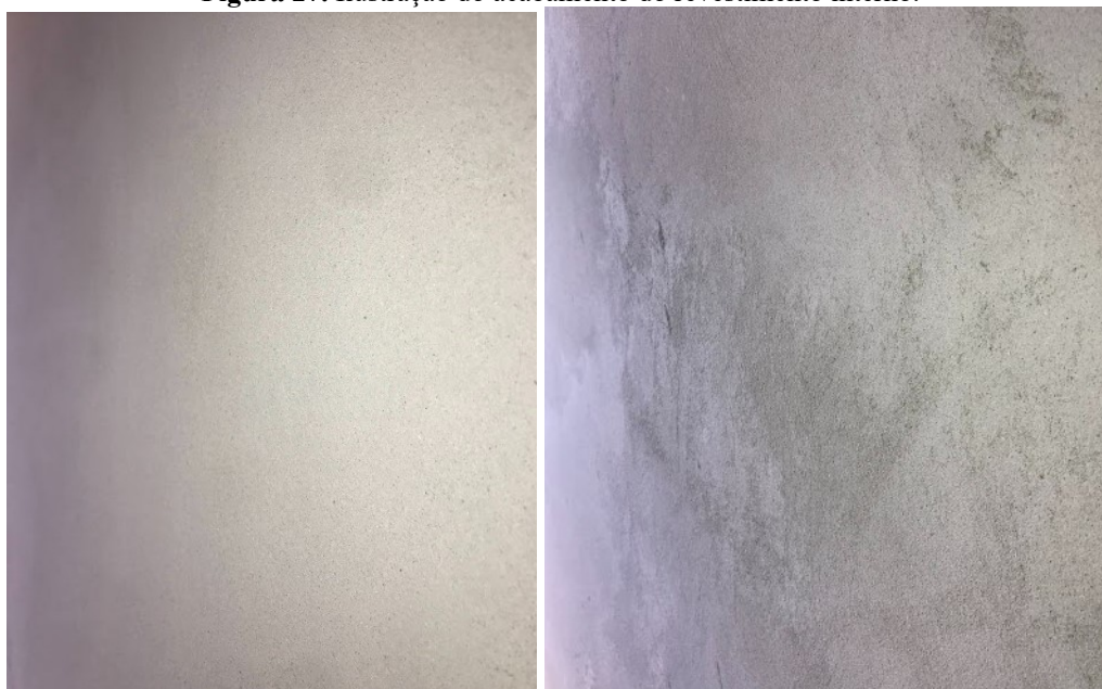
(a) Acabamento do revestimento ideal, liso, nivelado, sem protuberâncias ou ranhuras. (b) Acabamento do revestimento inadequado, áspero e irregular, precisa de reparo
