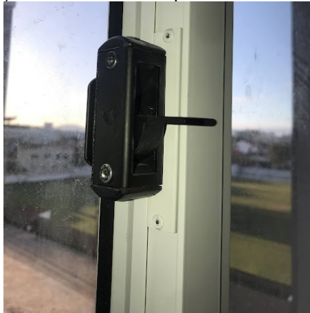
Figura 18. Peça de travamento da esquadria não fecha completamente.
