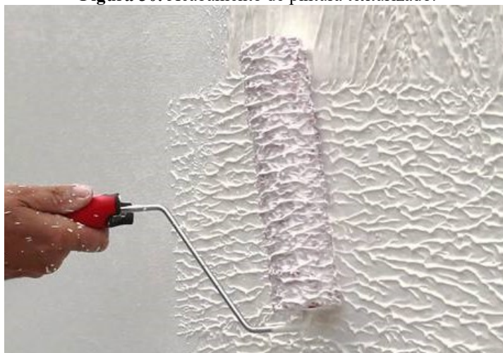
Figura 30. Acabamento de pintura texturizado.
