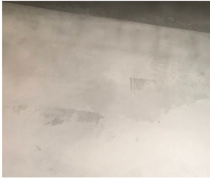
Figura 7. Acabamento do revestimento interno áspero e irregular.
