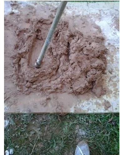
Figura 21 ( argamassa sendo misturada )
