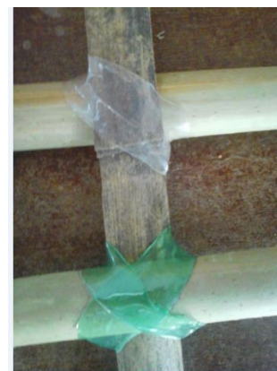
Figura 12/Corte das varas Figura 13/Trama em bambu com pet Figura 14/ Detalhe junção com pet (Fonte: autoral)
