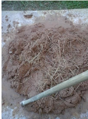
Figura 21 ( argamassa sendo misturada )
