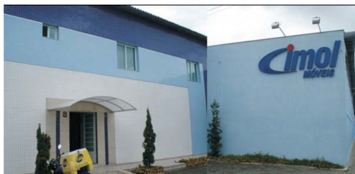
Figura 01: Fachada da Cimol
