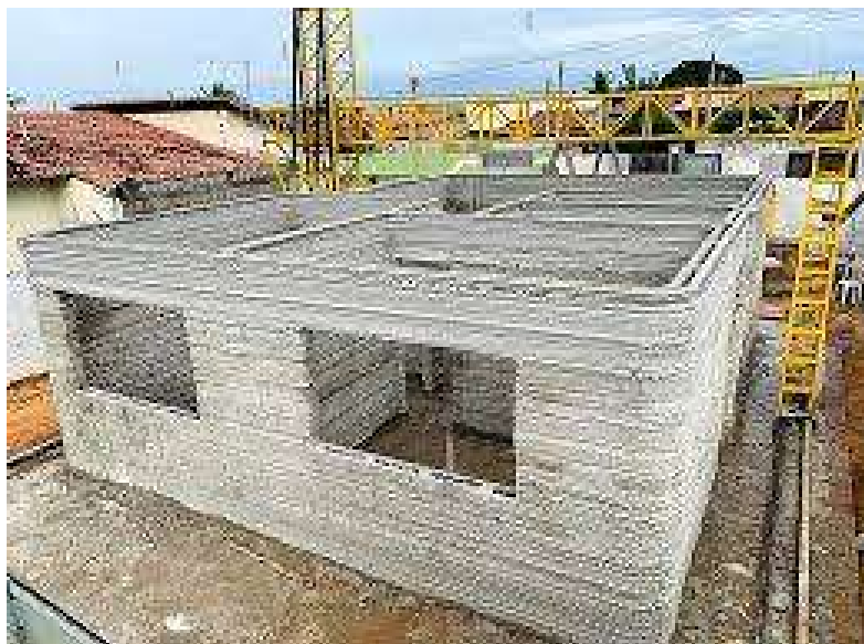
Figura 12- Primeira casa construída em impressão 3D no Brasil. Fonte: 3DHomeConstruction (2022).
