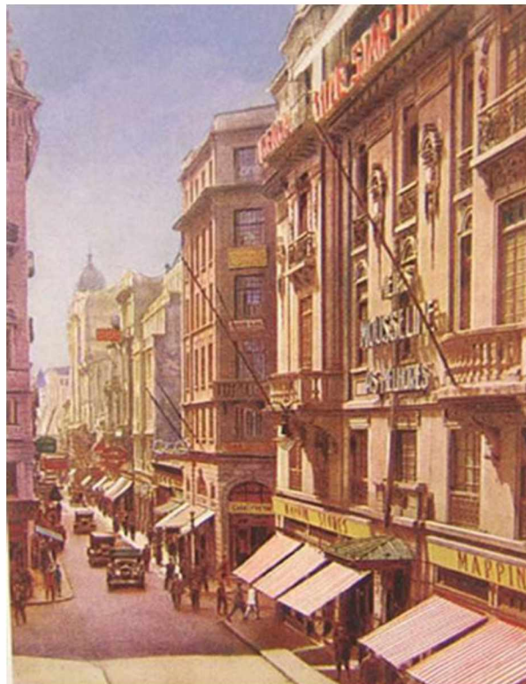
Imagem 18: Rua de São Bento
