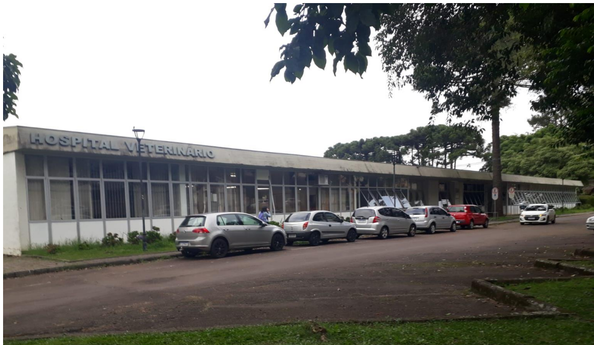
Figura 1. Fachada do Hospital Veterinário da Universidade Federal do Paraná.
