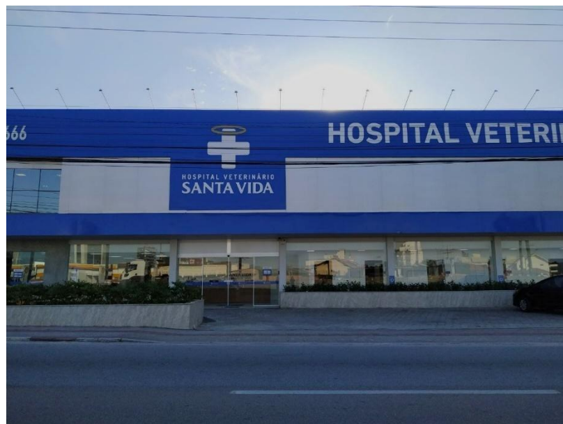
Figura 1 – Fachada do Hospital Veterinário Santa Vida.
