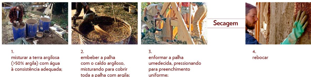
**Figura 7: Confeção de uma parede em argila-palha. Fonte: LAPORTE, 2015, adaptado pelo autor.**
