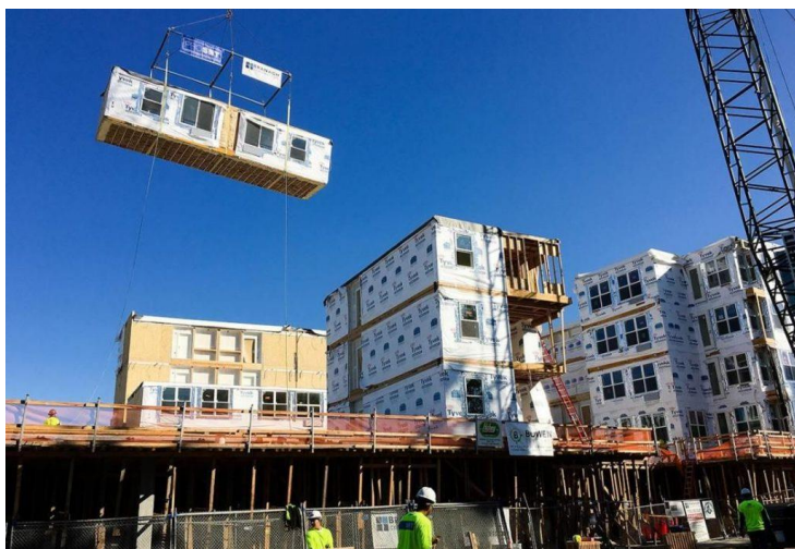
Figura 27 - Instalações dos módulos em obra
