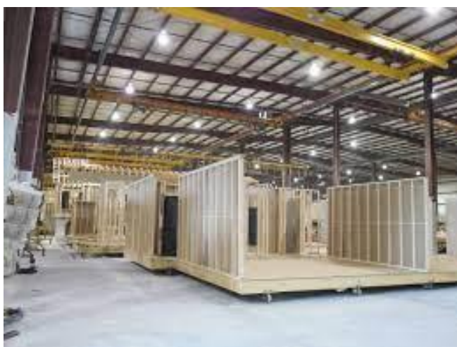
Figura 26 - Processo de montagem dos módulos
