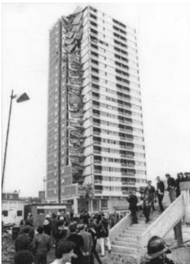
Figura 29 - Edifício Ronan Point após colapso
