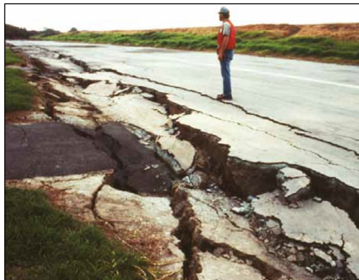
Figura 12 – Espalhamento lateral devido ao terremoto Loma Prieta, em 1989.
