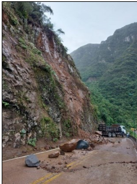
Figura 8 – Queda de rocha na Serra do Rio do Rastro – SC.
