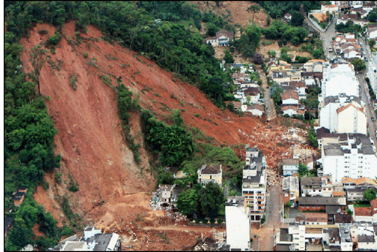
Figura 11 – Deslizamento translacional em Nova Friburgo – RJ.
