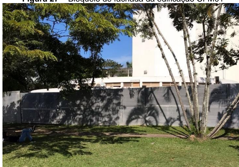
Figura 27 – Bloqueio de fachada da edificação CFM01
