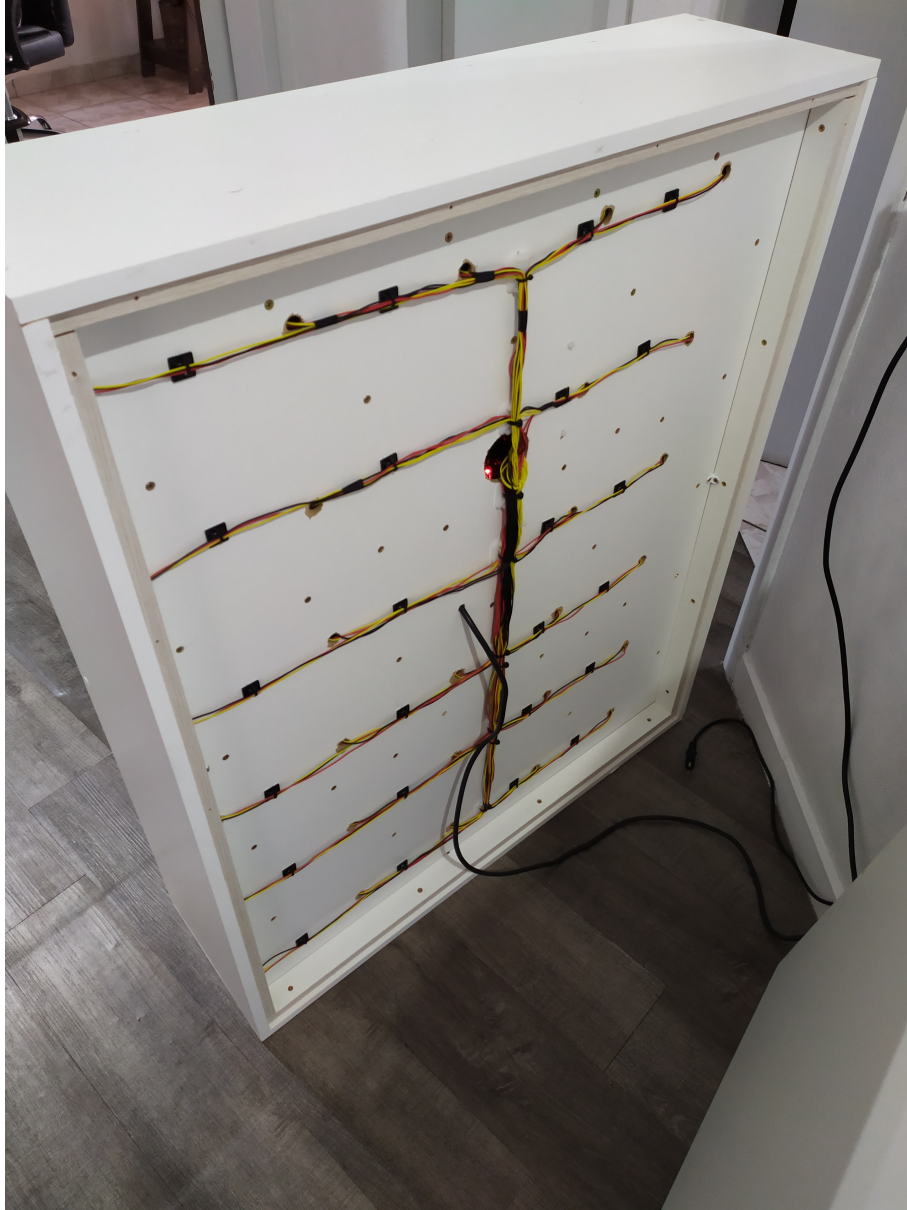
Figura 50 – Armário com a tampa de trás aberta, é visível o chicote que faz a ligação das fechaduras com a placa auxiliar.
