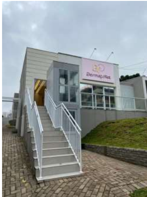
Figura 1 - Fachada da clínica veterinária DermatoVet
