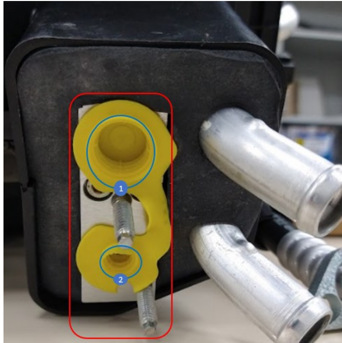
Figura 15 - Posição do dispositivo de expansão
