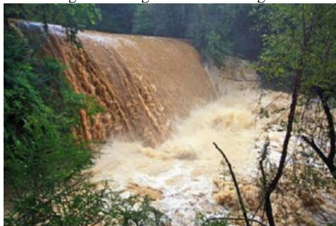
Figura 4. Galgamento na Barragem.
