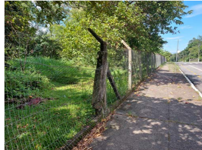
FIGURA 03 - Cerca deteriorada. FONTE: Autoria própria.
