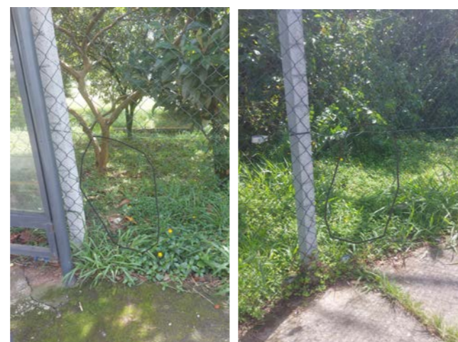
FIGURA 06 - Ponto de violação na cerca trocada recentemente FONTE: Autoria própria.
