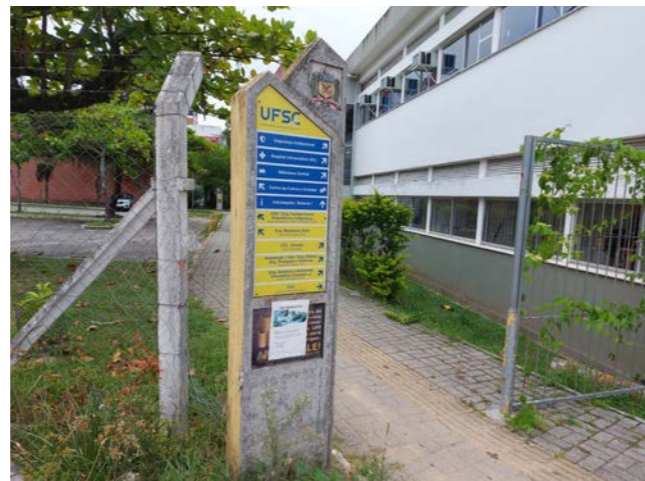
FIGURA 09- Portão para pedestres sem emenda com a cerca, podendo passar uma pessoa pela lateral. FONTE: Autoria própria.
