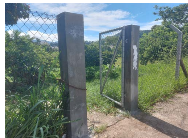
FIGURA 05 - Novo portão para pedestres FONTE: Autoria própria.
