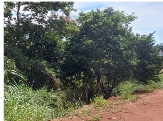
FIGURA 04 - Cercamento abaixo do nível da via e encoberto pelo mato. FONTE: Autoria própria.
