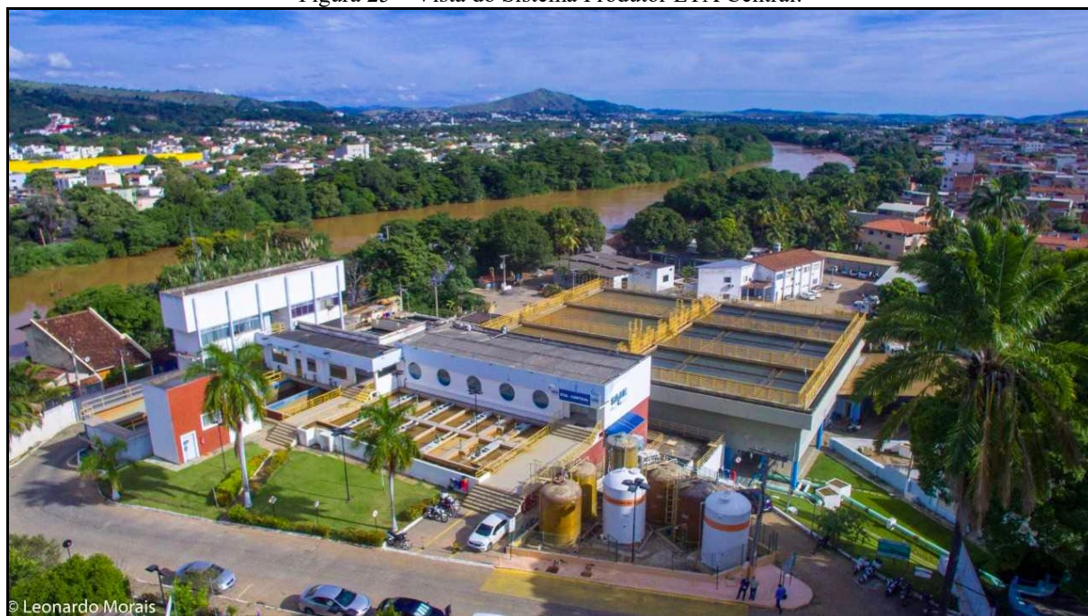
Figura 25 – Vista do Sistema Produtor ETA Central.
