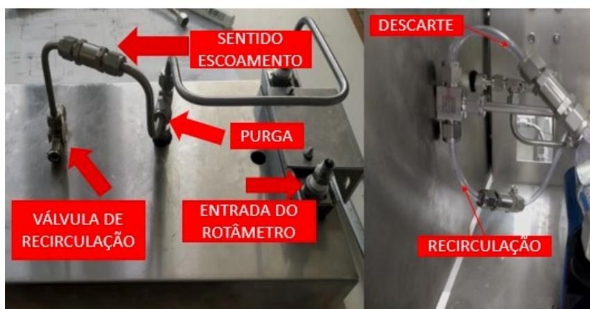
Figura 22 – Instalação das linhas de purga e recirculação/descarte (preparação e instalação).
