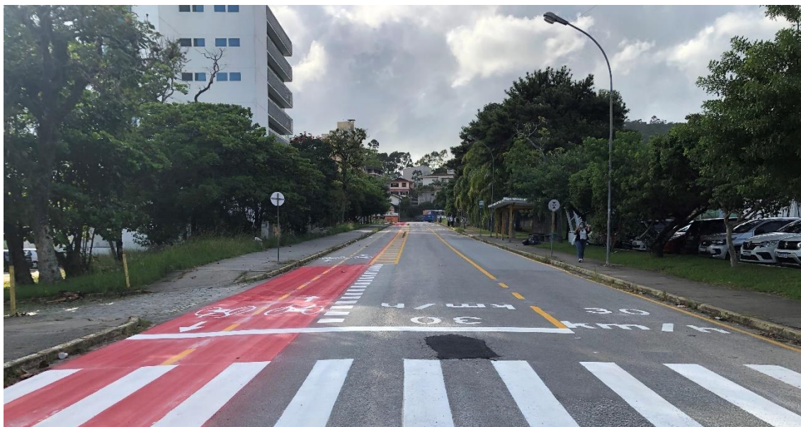
Figura 2– Sinalizações verticais e horizontais e ciclofaixa feita na Rua Engenheiro Agrônomo Andrey Cristian Ferreira
