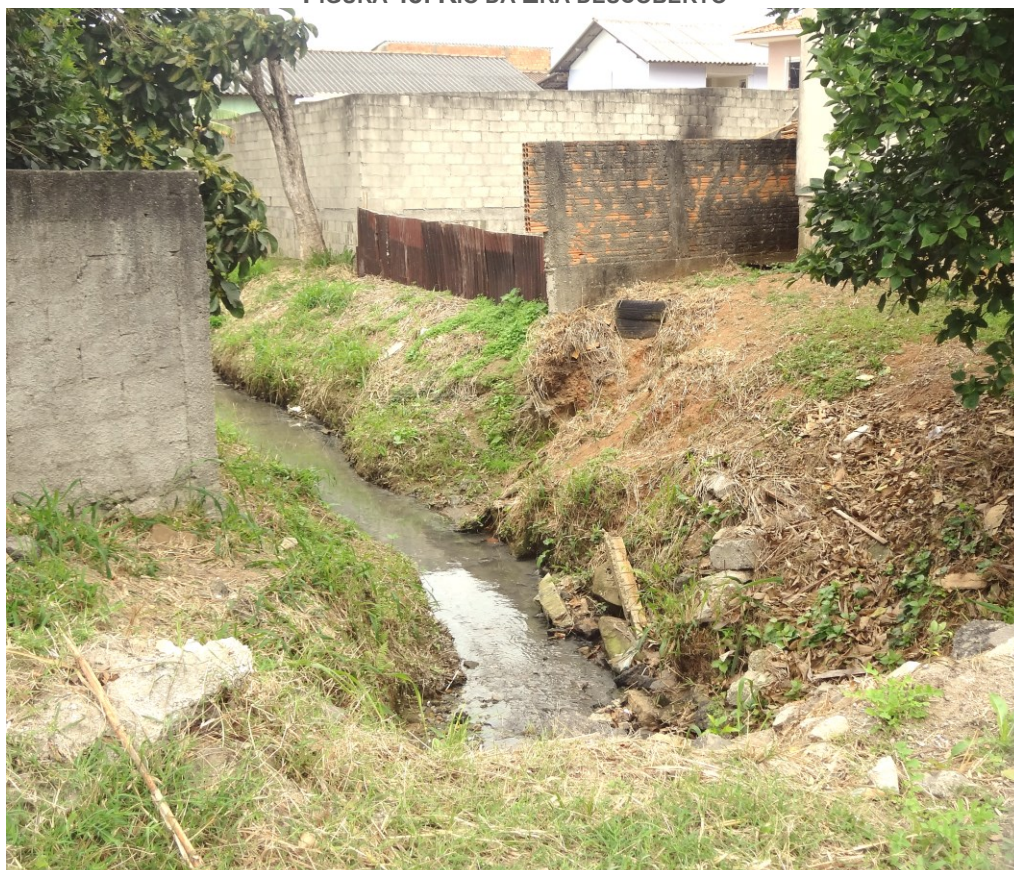
FIGURA 48: RIO DA ÈRA DESCOBERTO
