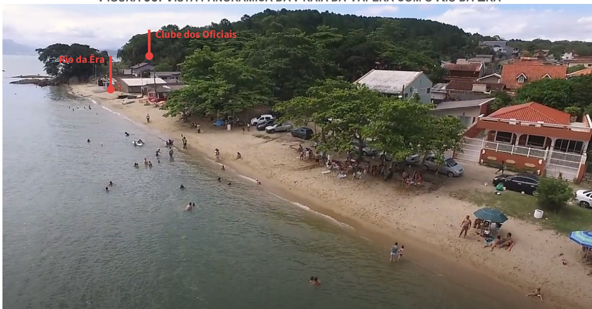
FIGURA 55: VISTA PANORÂMICA DA PRAIA DA TAPERA COM O RIO DA ÊRA
