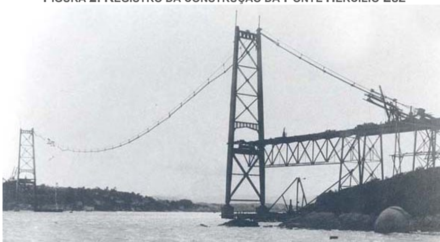
FIGURA 2: REGISTRO DA CONSTRUÇÃO DA PONTE HERCÍLIO LUZ
