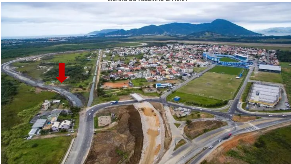
FIGURA 7: OBRAS DO NOVO ACESSO DO AEROPORTO INTERNACIONAL DE FLORIANÓPOLIS, AO FUNDO O MORRO DO RIBEIRÃO DA ILHA
