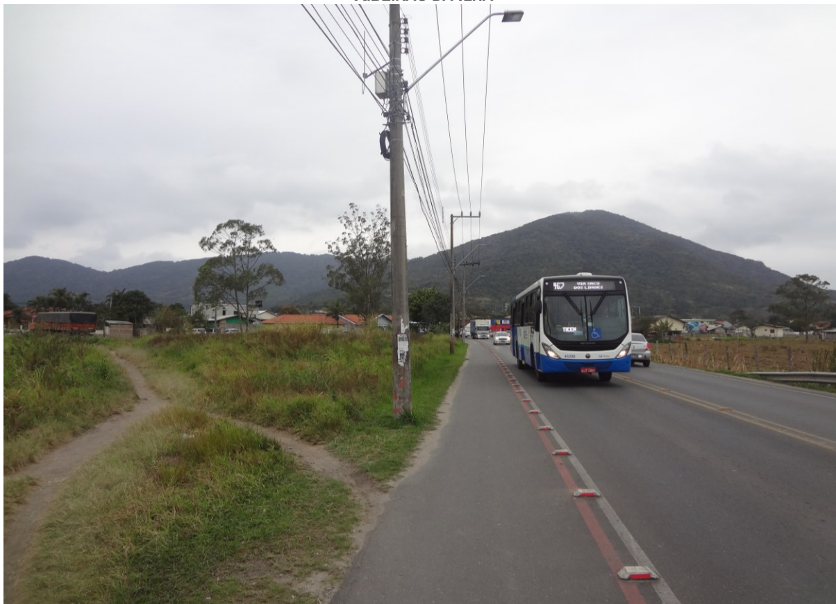
FIGURA 8: INÍCIO DA RODOVIA AÇORIANA NA PARTE SUL DO BAIRRO, AO FUNDO O MORRO DO RIBEIRÃO DA ILHA
