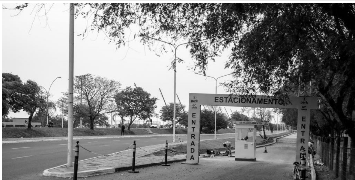
Figura 26 - Av. Edvaldo Pereira Paiva (via da esquerda) e o pórtico de acesso ao estacionamento fechado, em via pública. Esquerda, cercamento e vegetação do Parque Harmonia.
