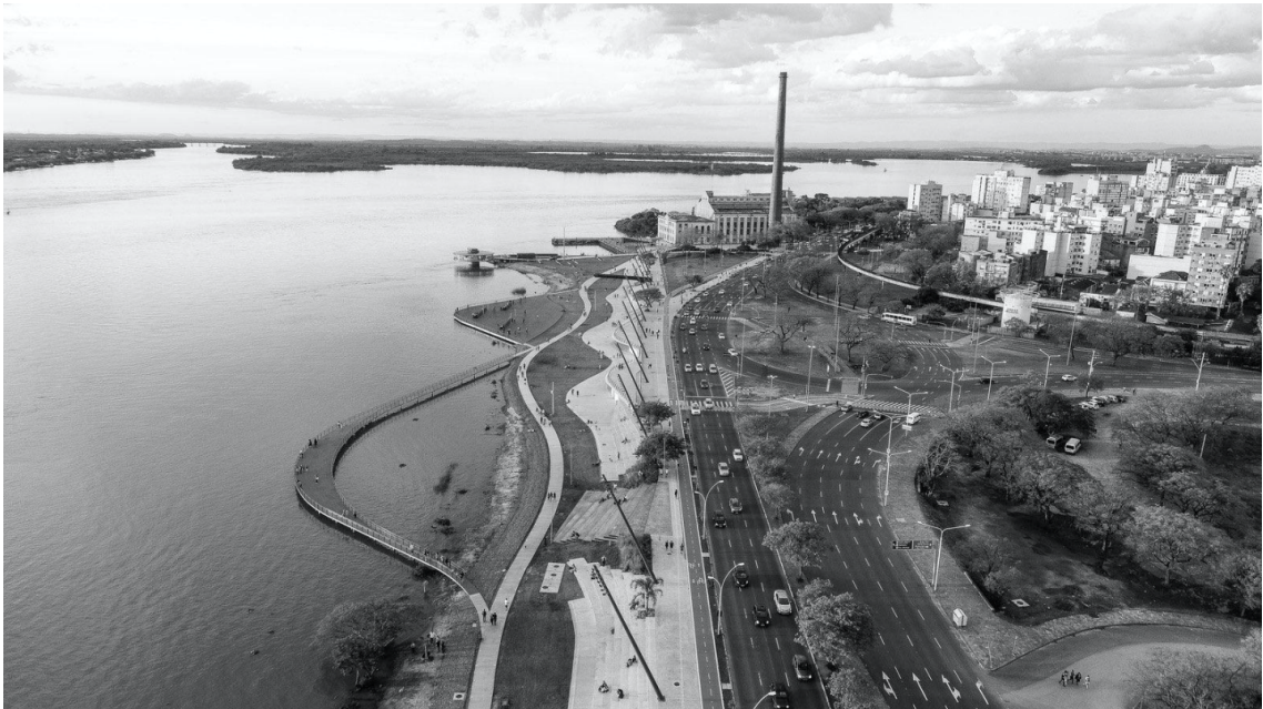
Figura 10 - Vista aérea da Orla Moacyr Scliar. Esquerda, a recente intervenção do parque e as diferentes faixas de uso da Av. Edvaldo Pereira Paiva. Direita, os edifícios do bairro Centro histórico. Ao fundo, a Usina do Gasômetro.
